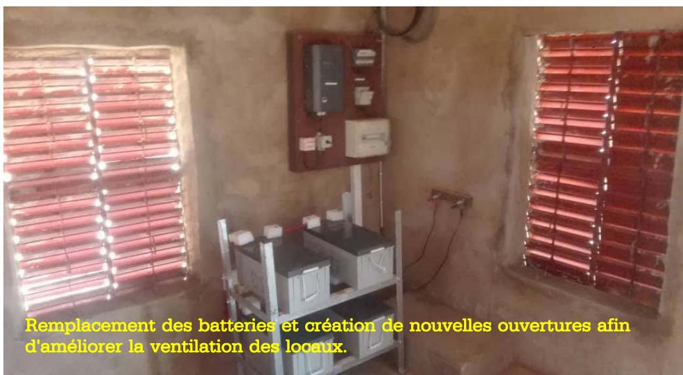
Remplacement des batteries et création de nouvelles ouvertures afin d'améliorer la ventilation des locaux.
